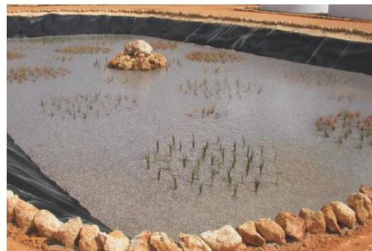
Figura 28- Aspecto de un Humedal Artificial Subsuperficial recién plantado
