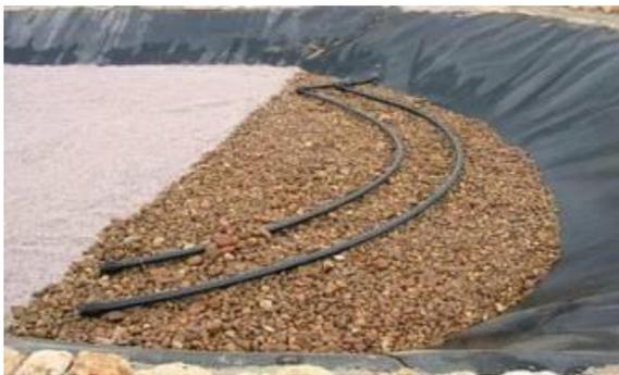
Figura 27- Tuberías de alimentación apoyadas en zona de cabecera
