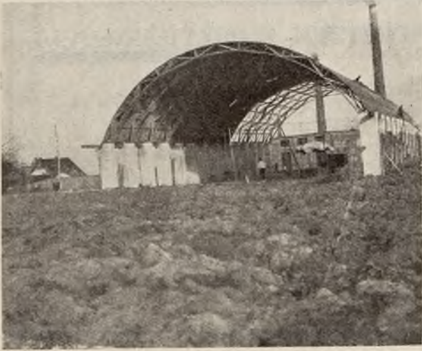
Hala tenisowa w Bydgoszczy, fragment budowy — dokładnie widoczna jest konstrukcja dachu
