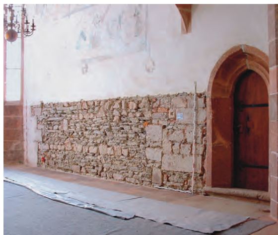
Abb. 12 Schlosskapelle, Südwand nach Abnahme jüngerer, flächiger Putze. In spätgotischer Bauphase (nach 1470) baulich veränderter Sakristei- zugang.
