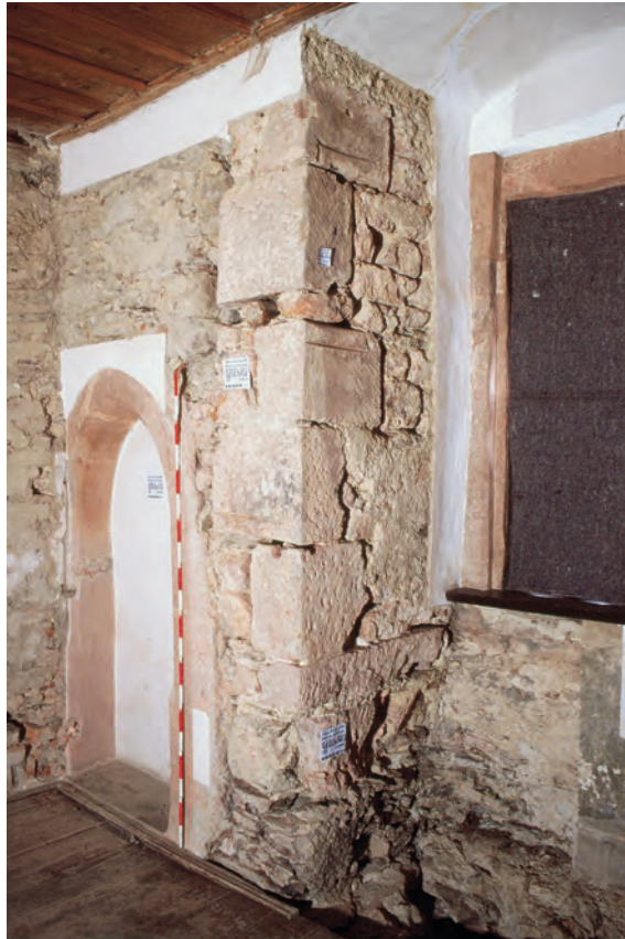
Abb. 7 Sekundär vermauerte romanische Werksteine (Seg- mente eines profilierten Rundbogens) in der Ostwand von »Turmzimmer 1«.
