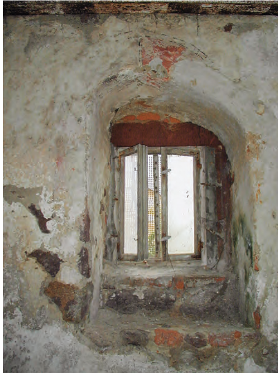
Abb. 7 Innenansicht der Vermauerung des Torbogens mit alternerender Rot-Weiß-Bemalung mit schwarzen Doppelfugen, vermutlich 15. Jahrhundert.
