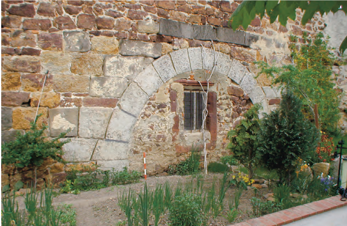
Abb. 8 Vermauerter Torbogen in der Westfassade des Hauses Burglehn 9, 2003.
