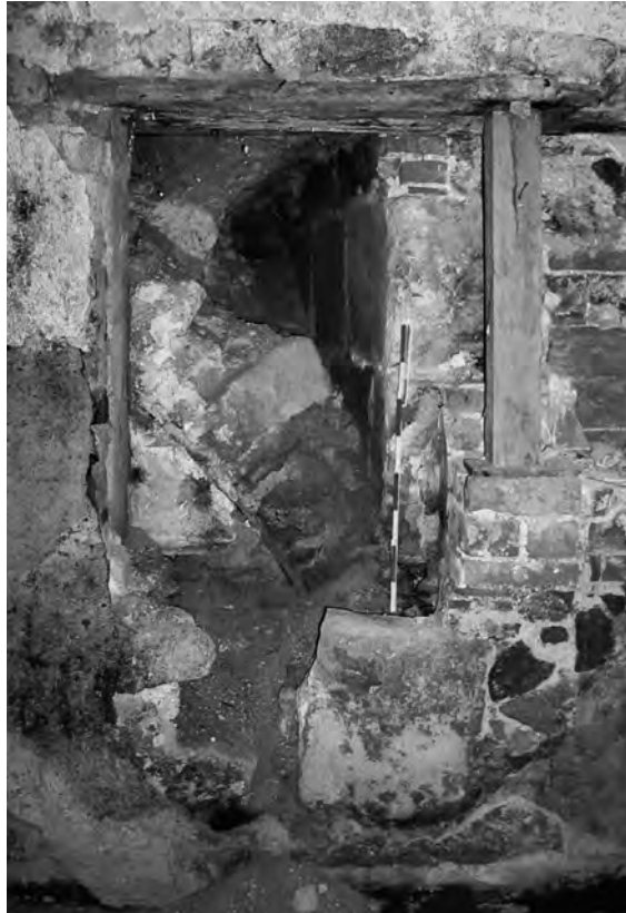
Abb. 9 Sekundärer Gewölbeansatz an der nördlichen Schenkel- mauer des Torbaues, 2003.
