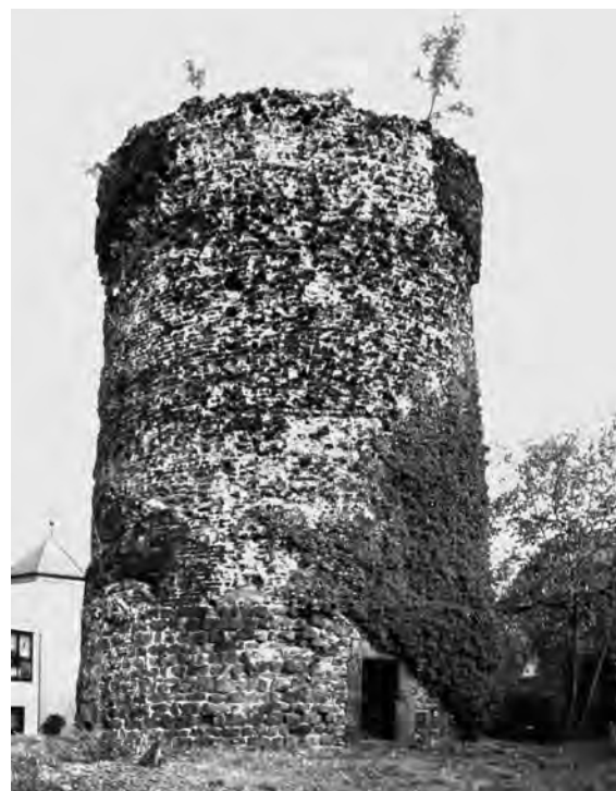
Abb. 4 Turm im Burglehn vor der Sanierung, Ansicht von Westen, 1999.
