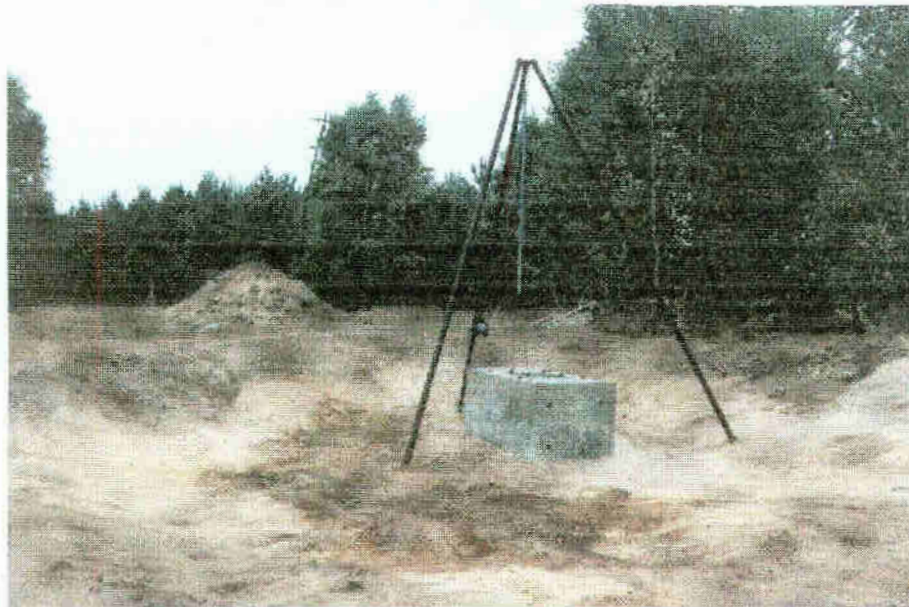
Rys. 3.6. Montaż bloku o wymiarach L \times B \times H = 1,6 \times 0,8 \times 0,7 m na dnie wykopu
