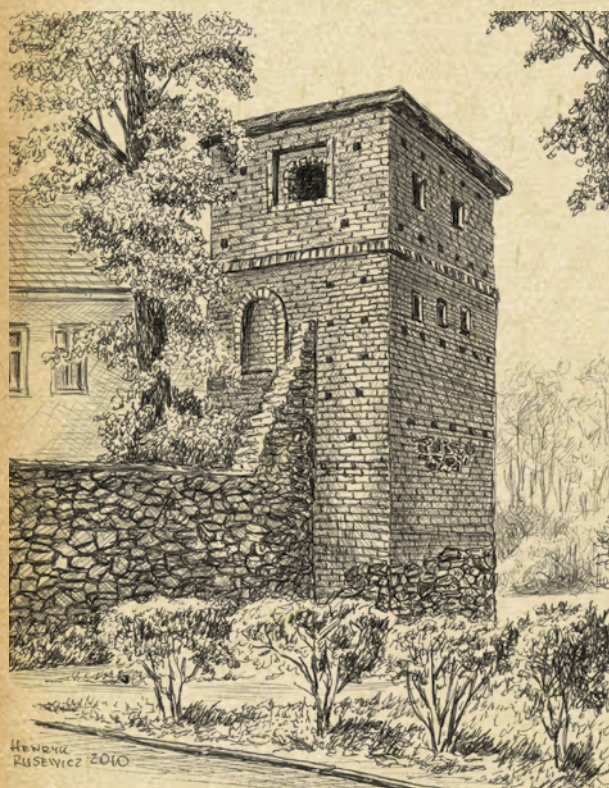
Baszta narożna w literaturze niemieckojęzycznej zwana basztą bluszczową
