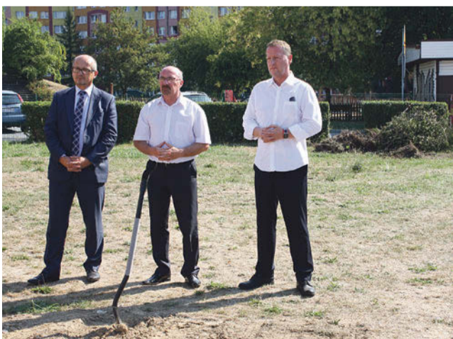
Pierwszą łopatę wspólnie wbili prezydent Lubina Robert Raczyński, Adam Myrda, starosta powiatu lubińskiego i Jarosław Wantuła, prezes Miejskiego Przedsiębiorstwa Wodociągów i Kanalizacji w Lubinie
