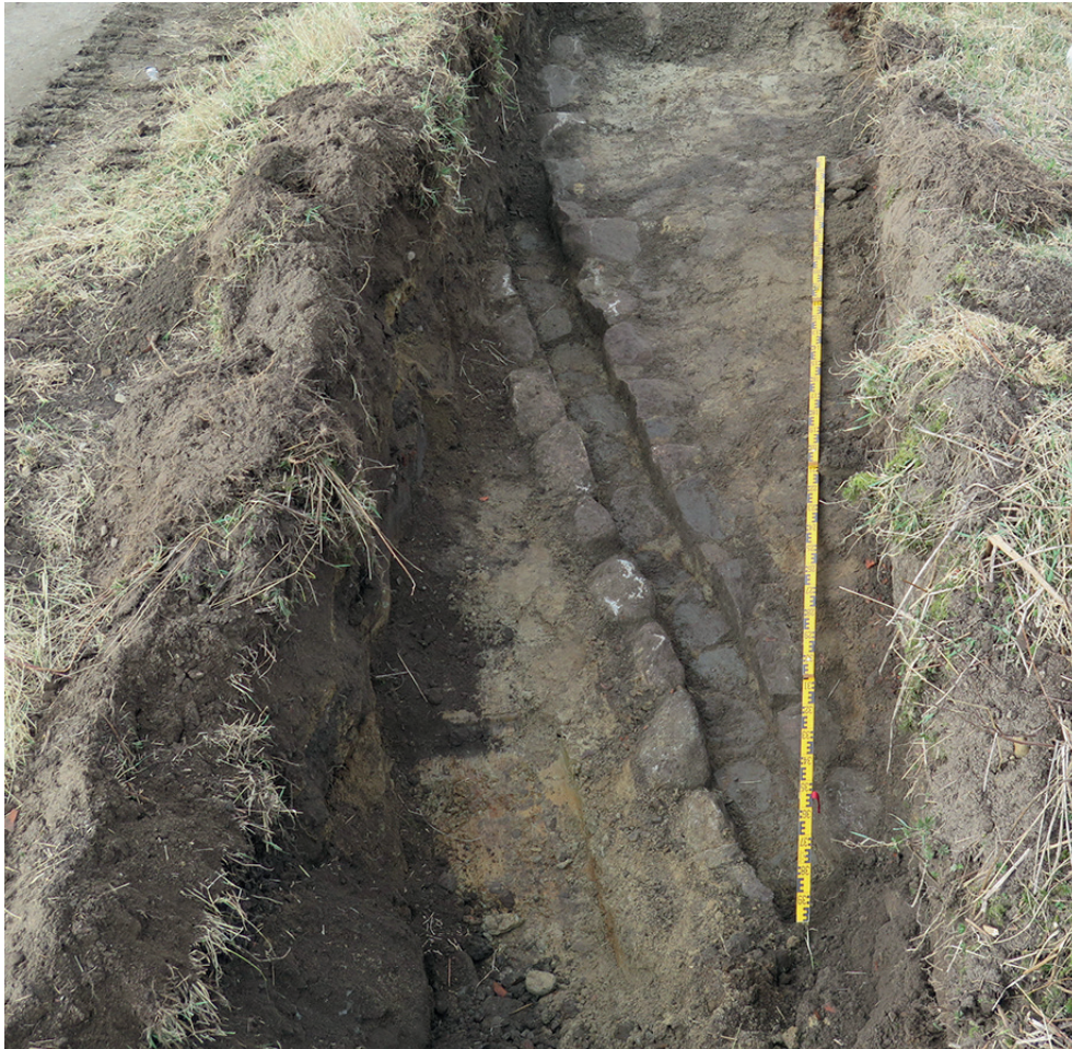
Figur 15. Stensatt vattenränna (A7) i schakt 3. Foto mot nordost.
