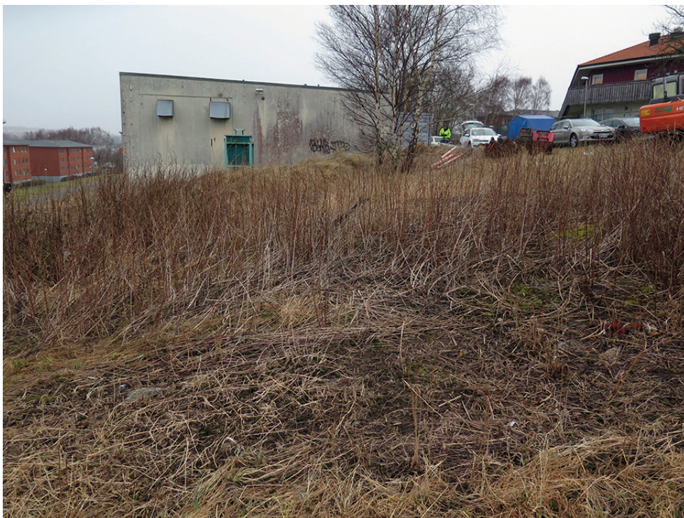
Figur 4. Äldre panncentral inom förundersökningsområdet i Pilegården. Foto mot nordost.
