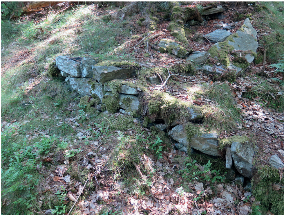
Figur 9. Objekt 3, terrassmur för stig/väg uppe i bergsslutningen på utredningsområdet. Foto mot nordost.
