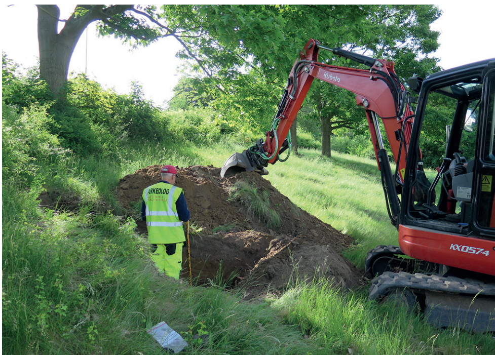
Figur 12. Grävning av schakt 1. Foto mot sydost.
