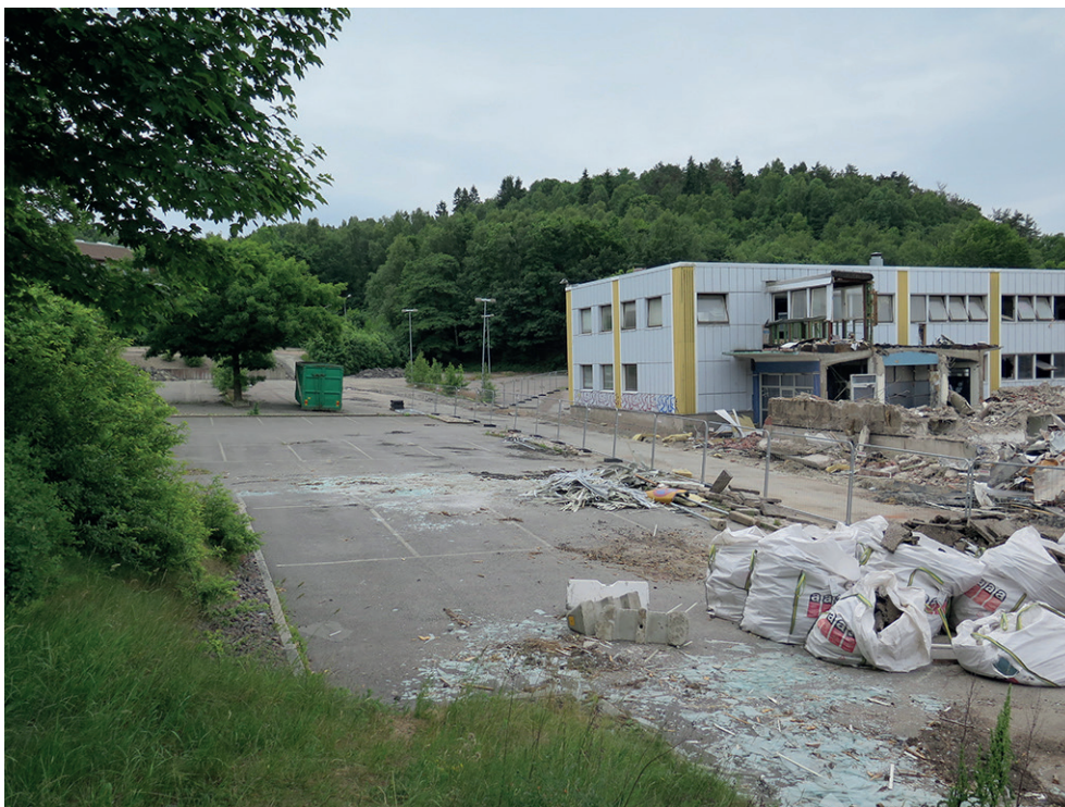
Figur 3. Rivningsområdet i utredningsområdets norra del samt bergsslutningen i områdets södra del där bakom. Foto mot söder.
