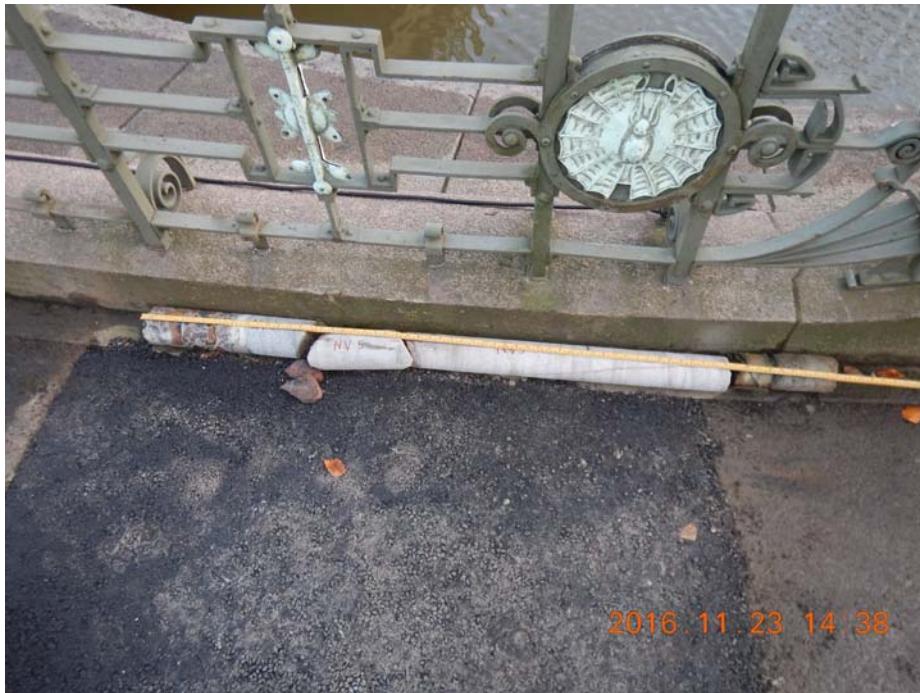
Figur 4. Borrprov från Vasabrons nordöstra landfäste. Provet visar betonggolvet, kallmurad stenmur samt rustbädd.
