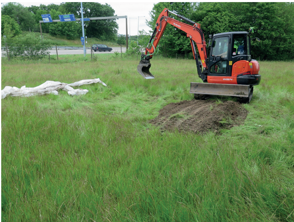
Figur 5. Schaktgrävning på fornlämning Björlanda 314:1. Foto mot nordväst.
