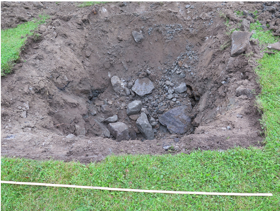
Figur 3. Grop 2, vilken tillsammans med grop 1 upptogs innan det större fjärrvärmeschaktet började grävas.
