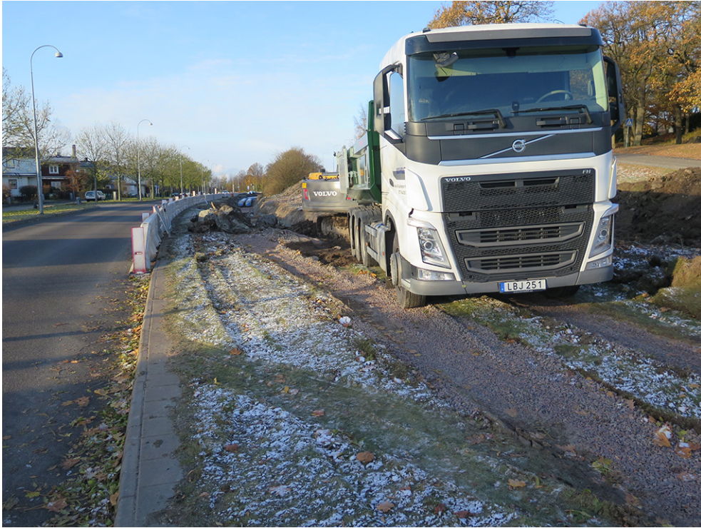
Figur 4. Från lastbilen och bakåt i bilden ser man fjärrvärmeschaktet. Foto mot SV.
