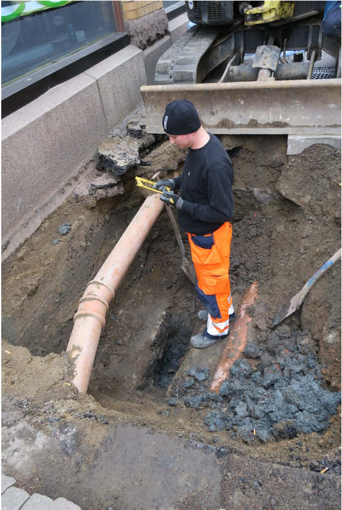
Figur 5. I schaktet fanns endast recenta fyllnadsmassor samt rör för dagvatten och fjärrvärme. En betongklack i botten av schaktet forcerades och under denna framkom omrörd lera och en träpåle. Enstaka föremål av 1700-1800-tals karaktär hittades i omrörda lager närmast husväggen. Dessa omhändertogs inte. Materialet tolkas komma från omflyttade kulturlager.
