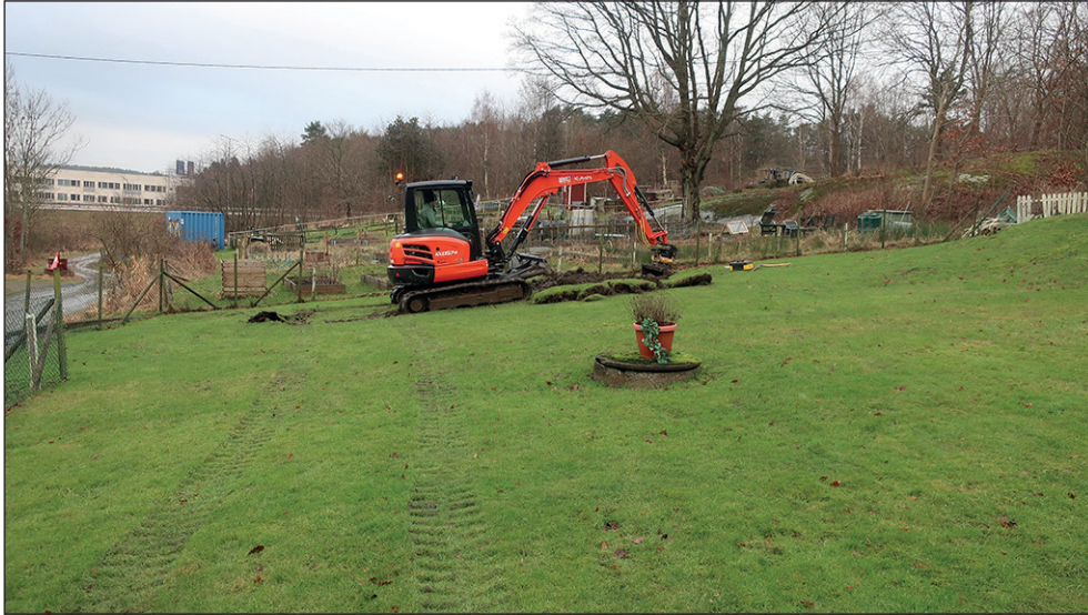
Figur 12. En mindre grävmaskin användes för att ta upp schakt inom utredningsområdet.
