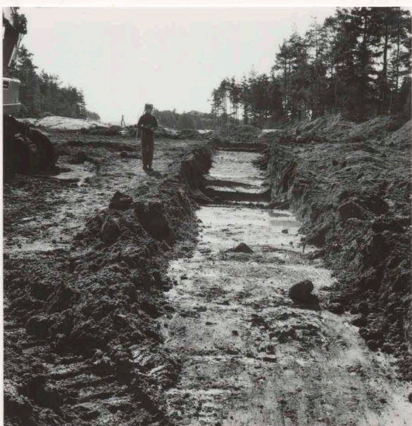
Fig 5. Neg. nr. B 10 024 Det maskingrävda schaktet mot söder. Schaktet grävdes endast ner till leran.
