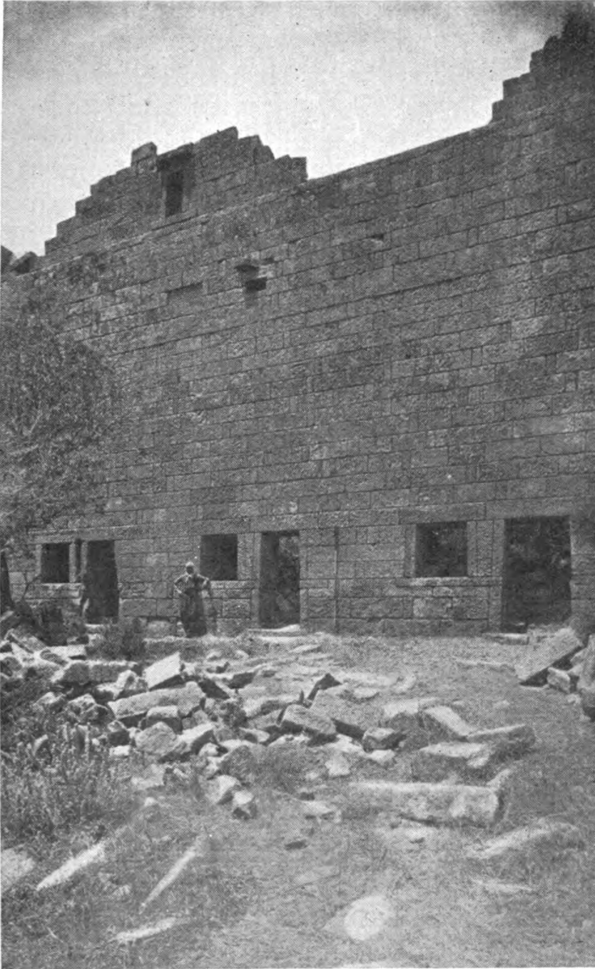
Abb. 22. Hellenistische Quaderwand des Marktes zu Aigai
