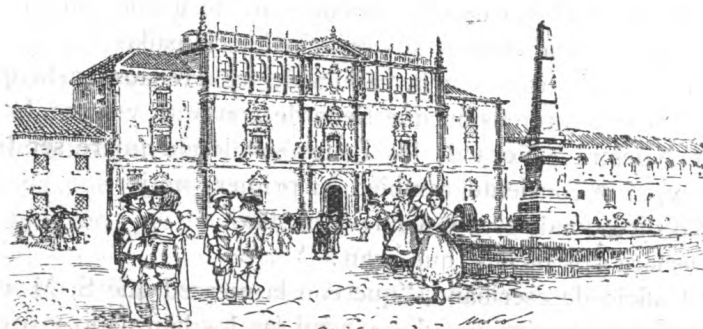
Fachada de la Universidad de Alcalá de Henares.
