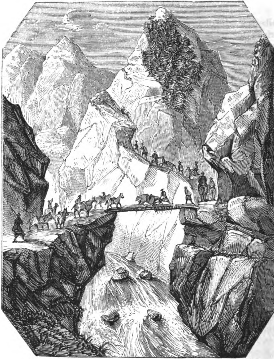
BRIDGE OF GHIAMDA.
