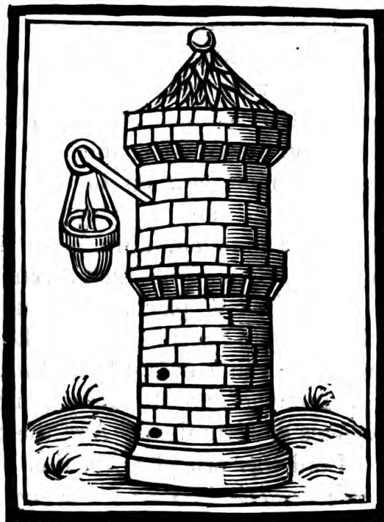
8 Que in circuitu operitur Plumbo, L.
