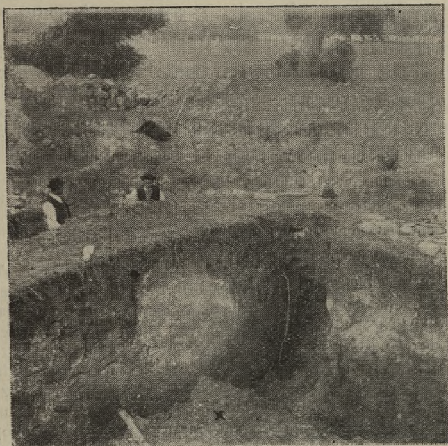
Fața externă a zidului, tencuită.
