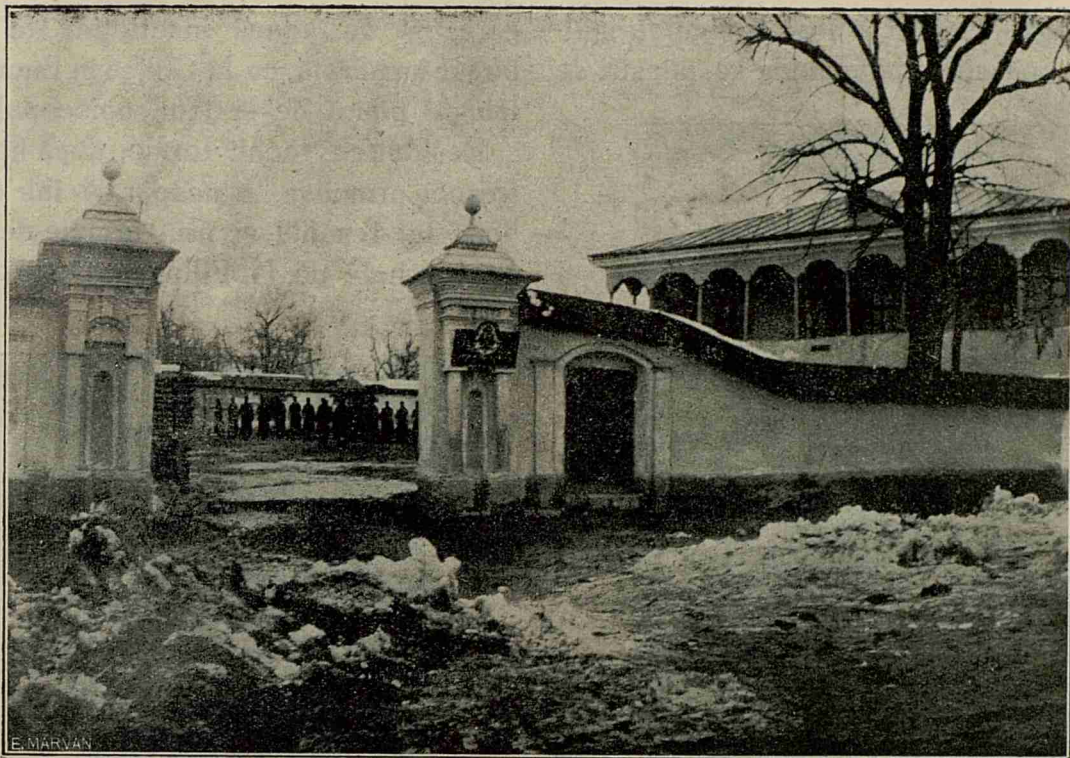
Fig. 10. Casa lui Mârzea din Vălenii-de-Munte.
