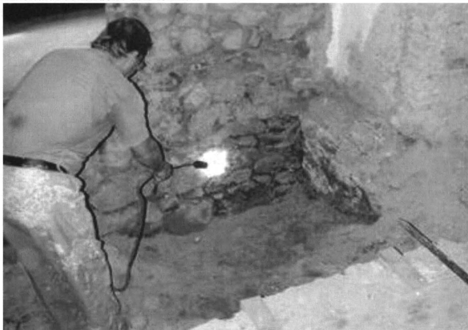
Tratarea termică a zidului infectat
