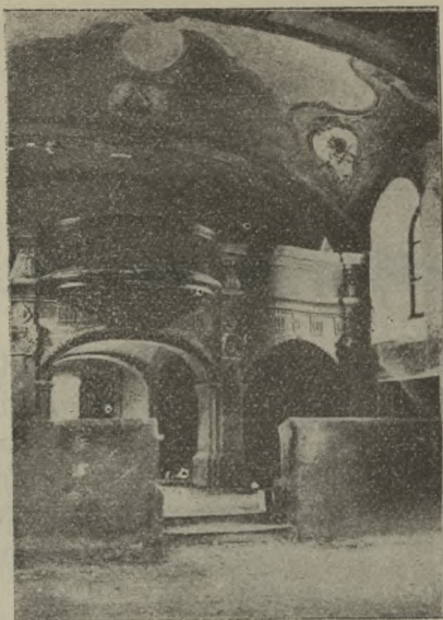
Vedere interioară spre cor înainte de restaurare
