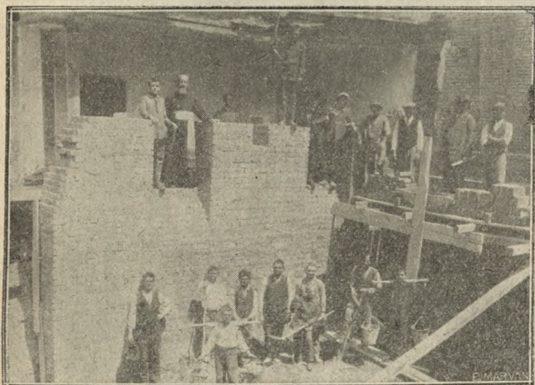
O vedere în timpul lucrărilor la subsol
