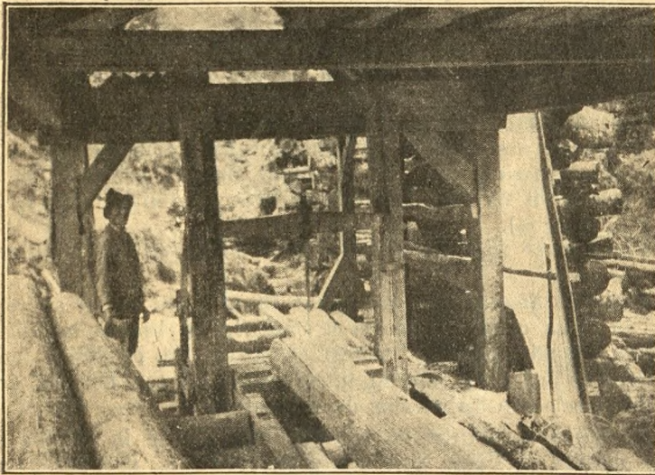
Fig. 11. Hala ferăstrăului de apă. (Fot. autorului)
