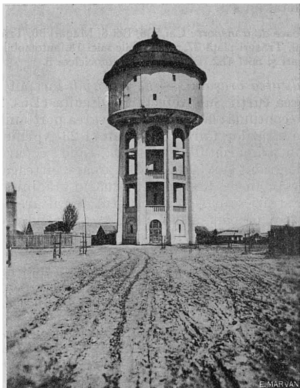
Rezervorul (Castelul de apă) distribuitor de apă filtrată la locuințele Oltenițenilor. Le château d'eau d'où l'on fait la distribution de l'eau filtrée.
